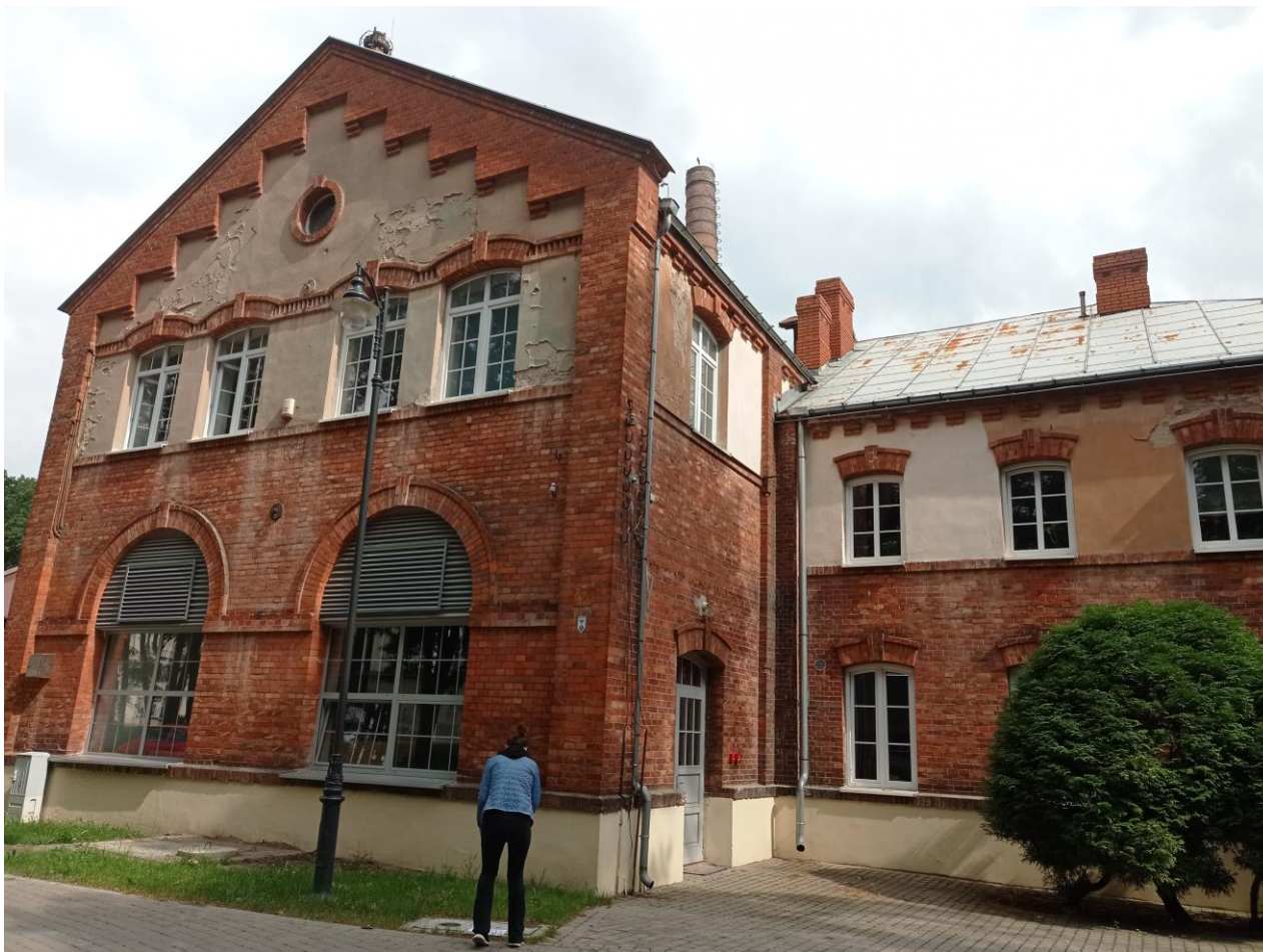
Fot. 3 Jedna z elewacji kotłowni przed rewaloryzacją
