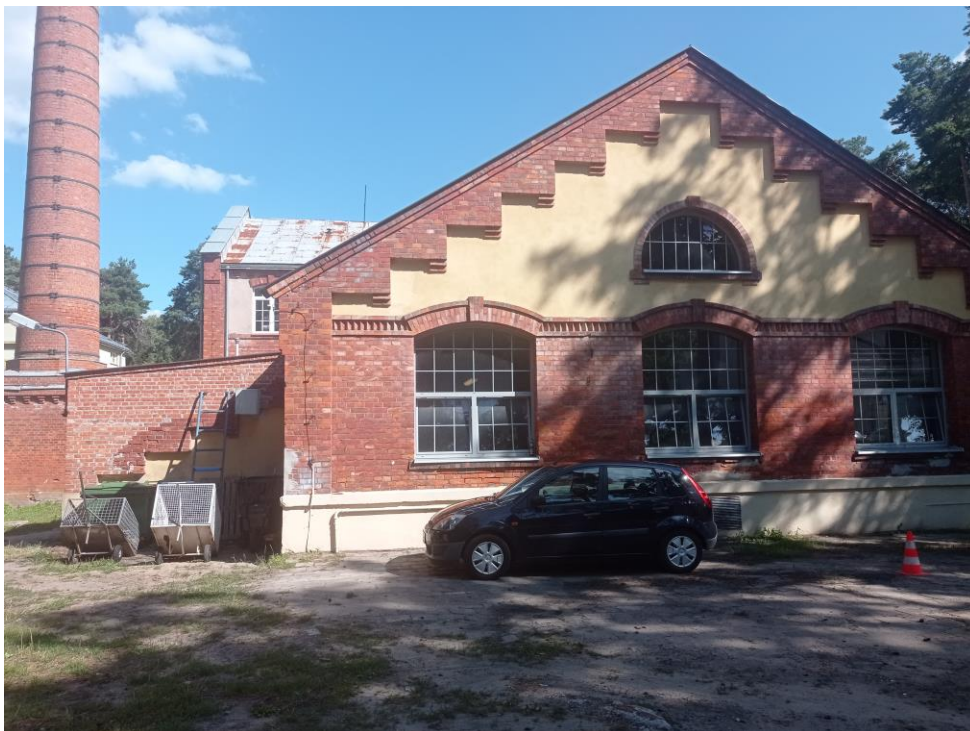
Fot. 1 Jedna z elewacji kotłowni przed rewaloryzacją
