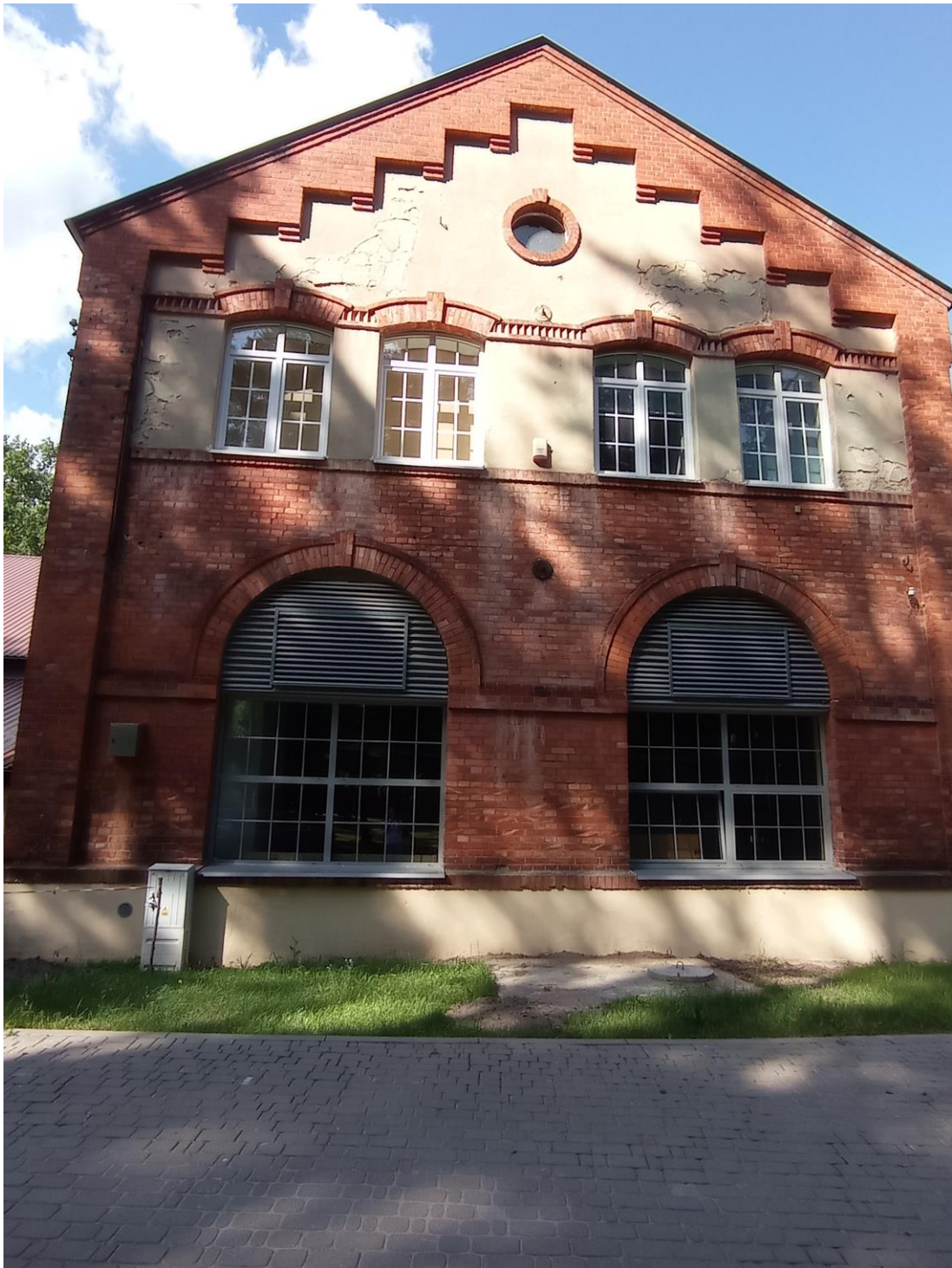
Fot. 2 Jedna z elewacji kotłowni przed rewaloryzacją
