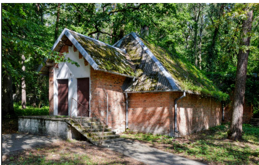
Fot. 5 Lodownia przed rewaloryzacją
