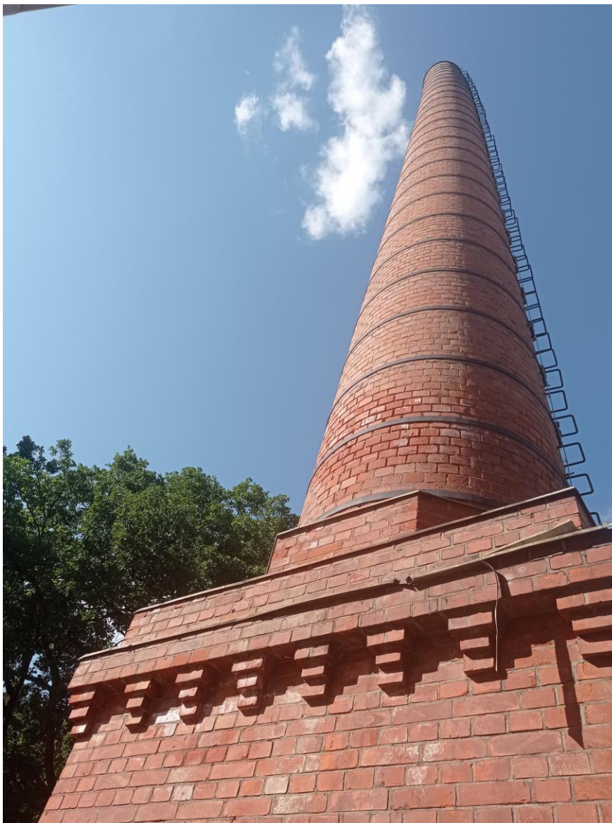
Fot. 4 Komin kotłowni przed rewaloryzacją
